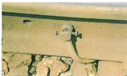
Spätne vedenie a jeho pripojenie na koľaj CuG 150 mm 2
