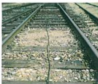
Spätne vedenie a jeho pripojenie na koľaj CuG 150 mm 2
